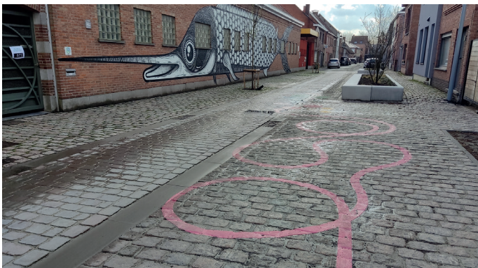
De heraanleg van het midden van de Crevestraat, tussen de openbare parking en het einde van de basisschool, is reeds uitgevoerd.
